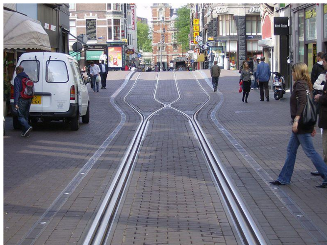
Exemple de voies imbriquées à Séville (Espagne)
